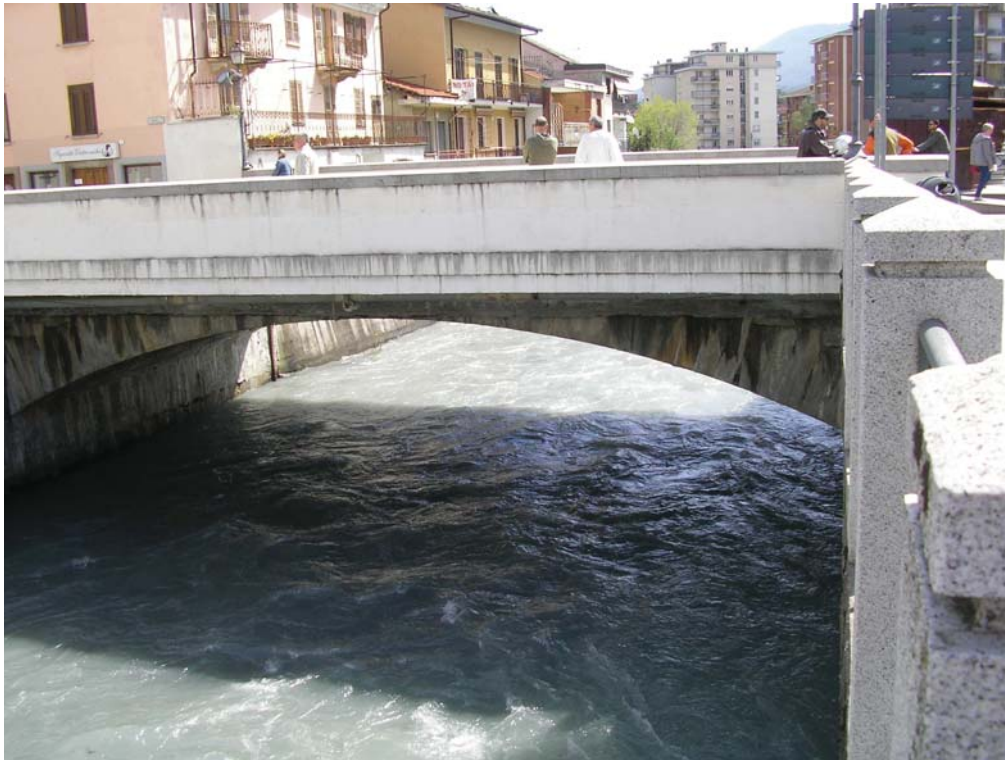
Figura 1. Ponte della SS 24 del Monginevro nel centro dell'abitato di Susa: il sottodimensionamento rispetto alle esigenze in caso di piena bicentenaria rende quest'opera incompatibile secondo lo studio idraulico dell'AdBPo
