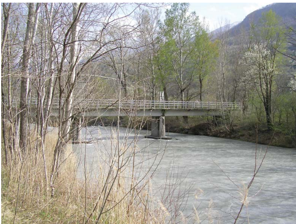
Figura 15. Il ponte di Via del Lago; come segnalato nello studio di fattibilità della sistemazione idraulica dell'AdBPo molti attraversamenti risultano non adeguatamente dimensionati per gli eventi di piena con tempo di ritorno ultracentenario
