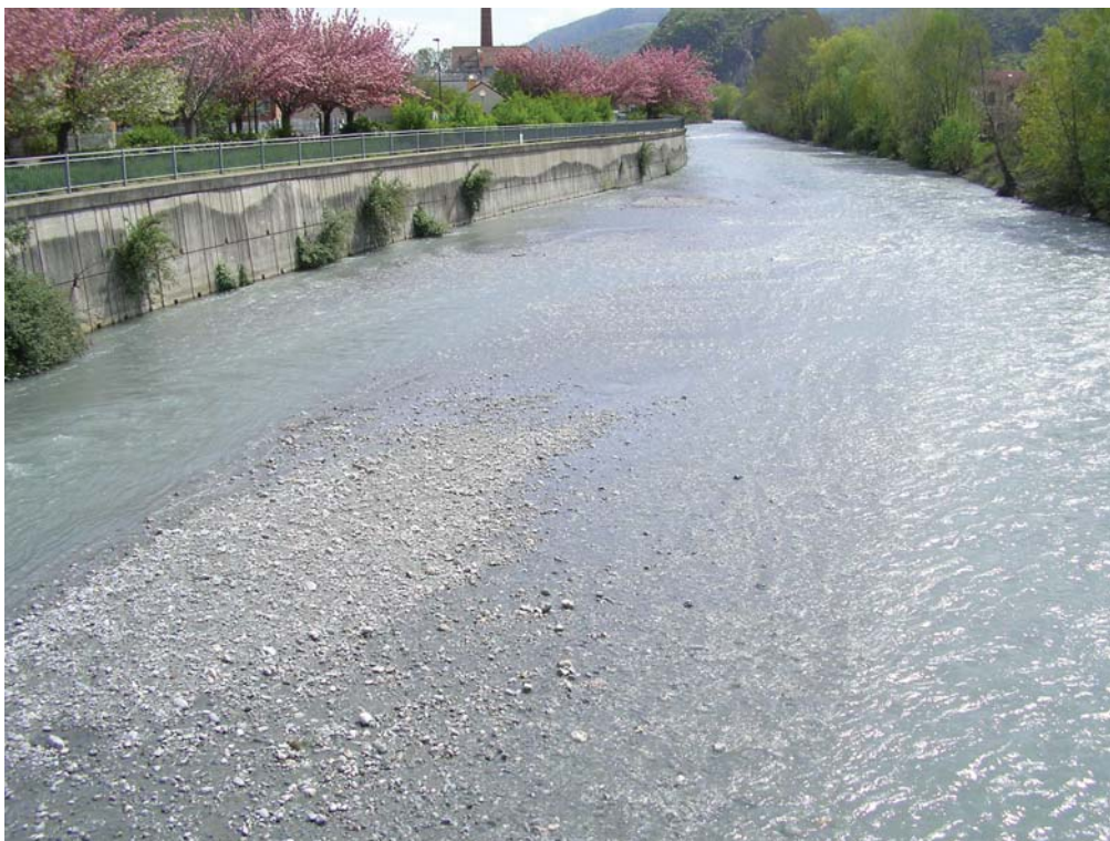
Figura 3. Susa: tratto a valle del Ponte Dalla Chiesa con muri a difesa dell'abitato in sinistra idrografica
