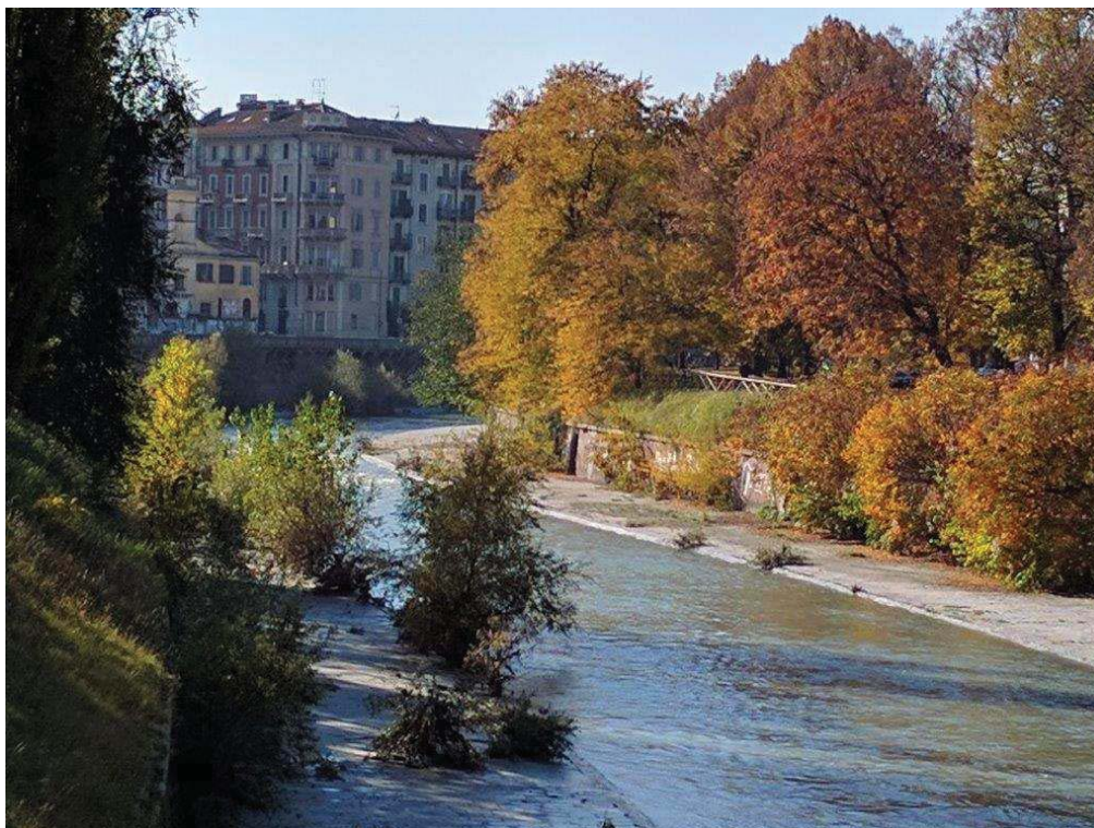
Figura 48. Tratto d'alveo difeso da muri arginali in cui progressivamente si è sviluppata la vegetazione arborea che andrà contenuta per evitare che rallenti il deflusso delle acque in caso di piena .
