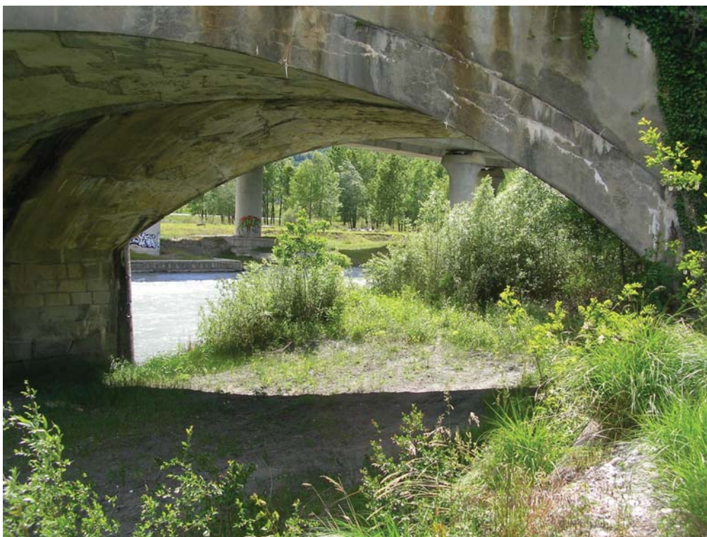
Figura 20. Ponte ferroviario nei pressi di San Valeriano, a valle del viadotto autostradale: le luci dei ponti devono essere mantenute sgombre dalla vegetazione per non ridurne la capacità di deflusso.
