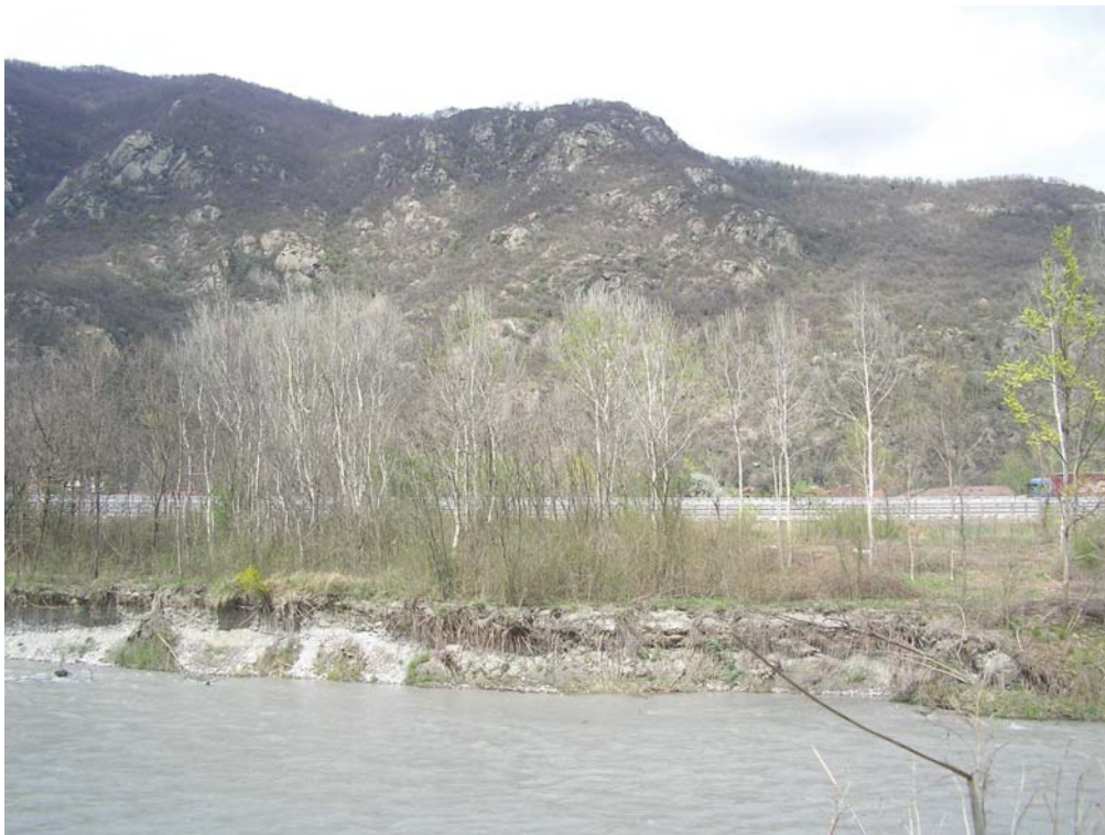
Figura 22. Lunata di erosione nei pressi di Sant'Antonino di Susa di fronte alla loc. Poisatto; il fenomeno, grazie anche alla diffusione di difese di sponda, appare limitato.
