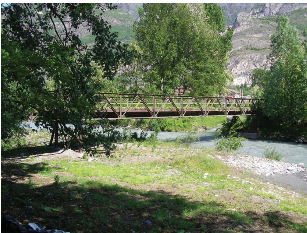
Figura 4. Bussoleno: passerella che oltre ad essere inadeguata e d interferente, secondo lo Studio di idraulico dell'AdBPo risulta anche in precarie condizioni di stabilità
