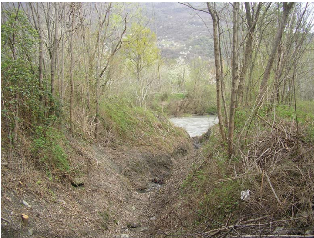
Figura 26. Canale di scolo, in destra idrografica, nel Comune di Sant'Ambrogio gestito correttamente con tagli periodici della vegetazione per permettere il regolare deflusso delle acque
