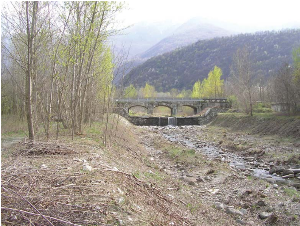
Figura 17. Torrente Gravio in destra idrografica; è stato di recente realizzato un intervento di manutenzione idraulica finalizzato ad eliminare la vegetazione radicata nell'alveo inciso e sulla sponda, in prevalenza costituita da pioppo nero
